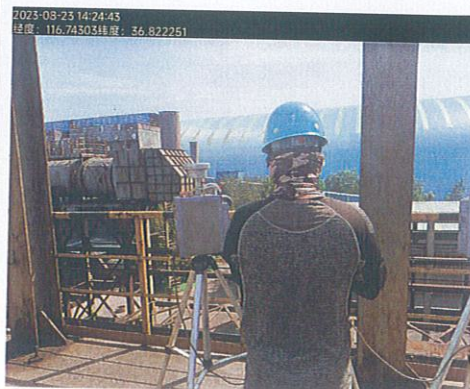
焦炉炉端焦侧的 2/3 处
