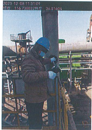
炭黑 6#再处理袋滤器排气筒 (DA033)
